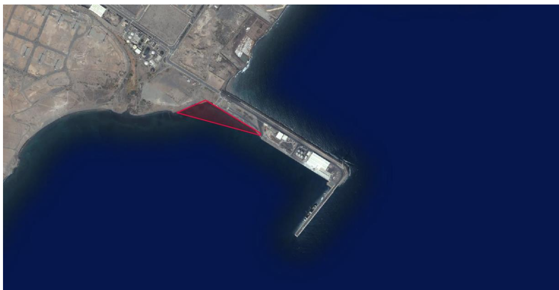
Actuación "Ejecución de rellenos interiores en el litoral de la zona sur del puerto de Arinaga"
